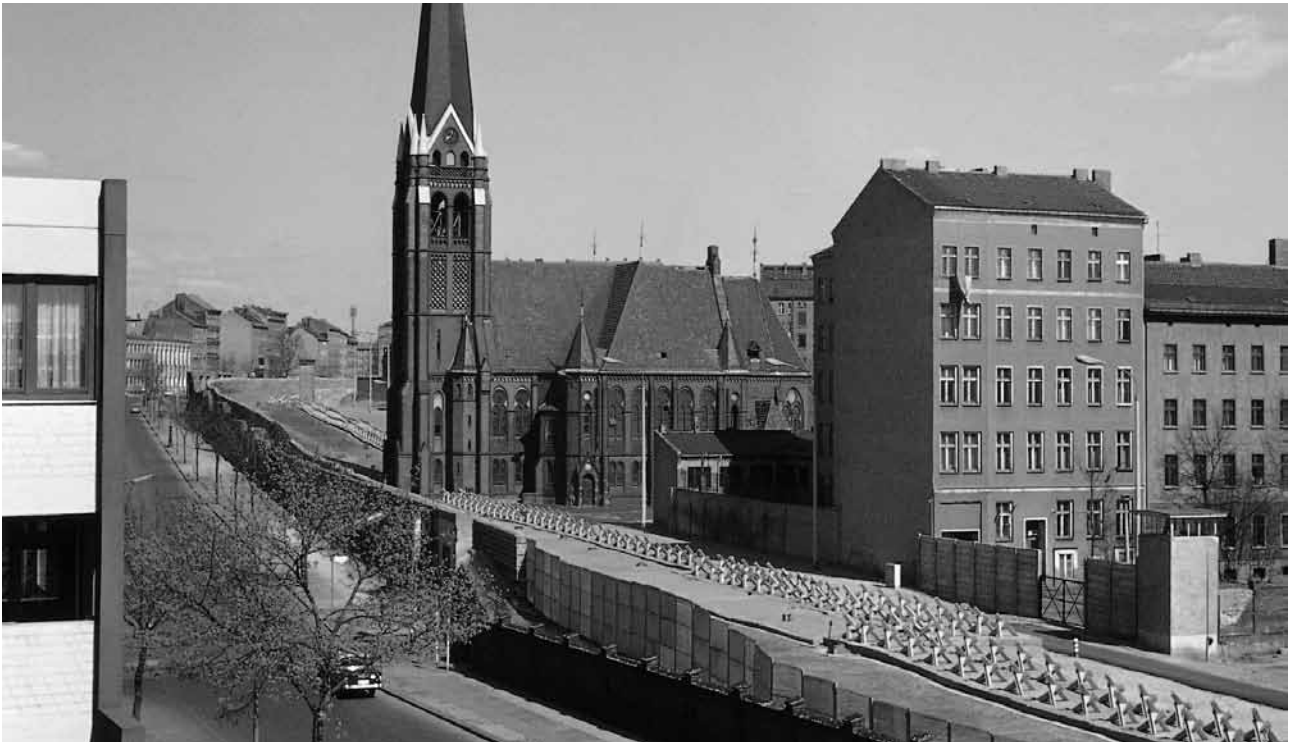
Fast 30 Jahre lang trennte die Berliner Mauer Osten und Westen – unter anderem auch entlang der Bernauer Straße, an der das Haus Lazarus gelegen ist.
